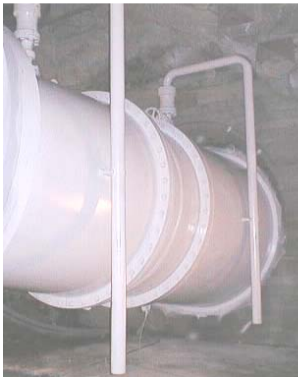
Figur 14.4 Eksempel på luftutslippingsventil
